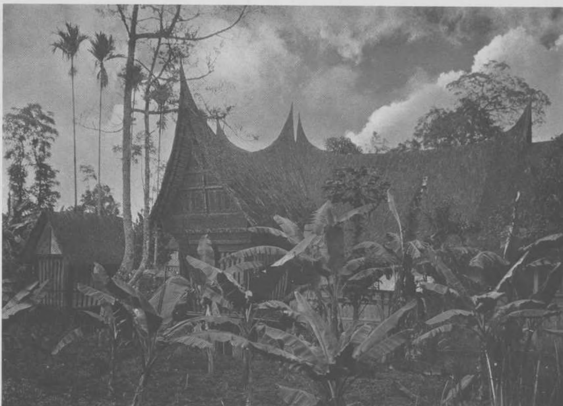
SUMATRA. Gezicht op een Menangkabausch huis. SUMATRA. One aspect of a Menangkabau house.
